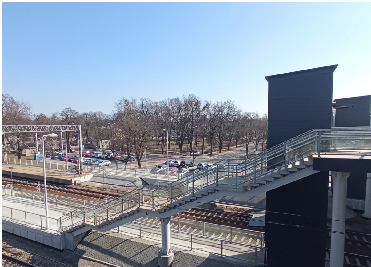
Fot. 14. ul. Dworcowa po remoncie (źródło: piastow.pl)
